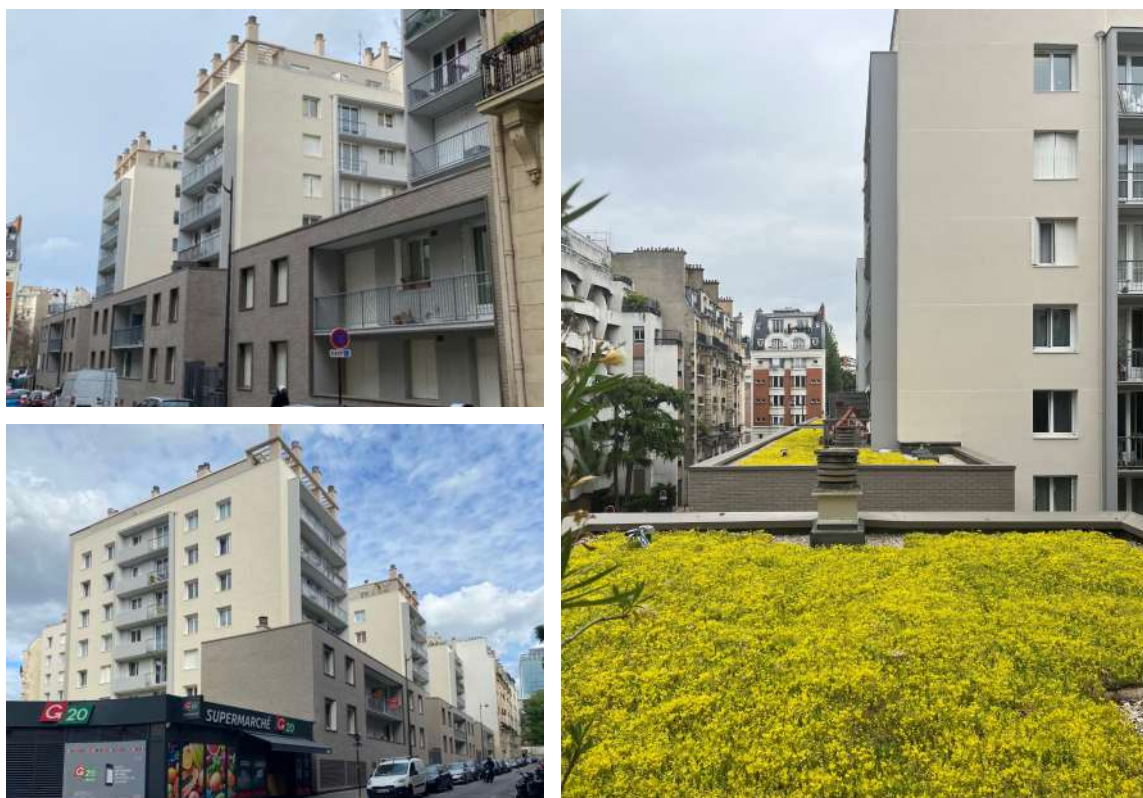
Végétalisation des toitures basses
