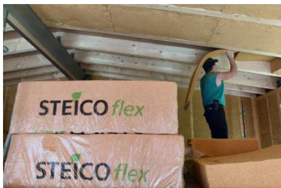
Installation de panneaux isolants en fibre de bois fabriqués en France sur un chantier à Mesnay, dans le Jura, en 2018
