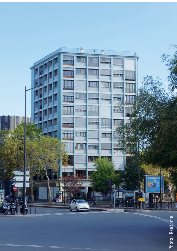
↑ Copropriété route de la Reine à Boulogne- Billancourt (92) : rénovation énergétique BBC et valorisation architecturale comprenant une nouvelle façade bioclimatique intégrant un dispositif de stores motorisés et une toiture-terrasse aménagée pour les activités d'agriculture urbaine. Consommations réduites de 55%. Trophée CoachCopro Agence Parisienne du climat 2019.
